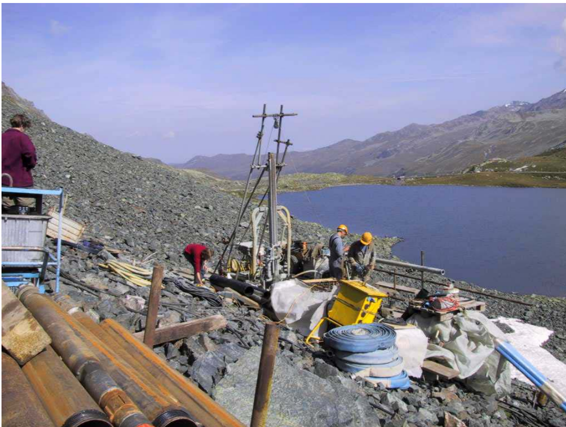
Figur 9: SLF – Permafrostbohrung am Schottensee (Flüelapass)
